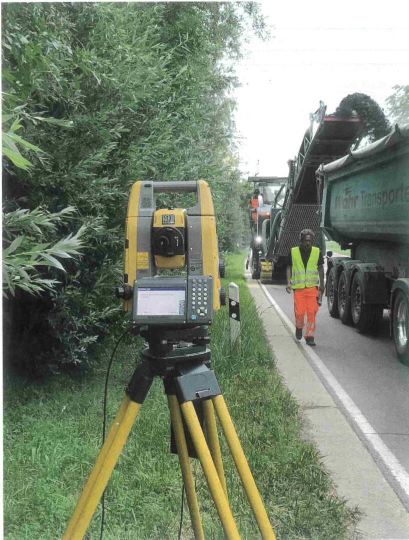
Abb. 3: 3D-Fräsen mittels Tachymetersteuerung auf der Pilotstrecke „L1138 Freiberg–Benningen“
