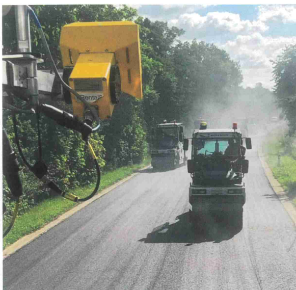
Abb. 10: Thermokamera und Echtzeitanzeige von Oberflächentemperaturen, System der Firma Moba (Quelle: Wolff & Müller)
